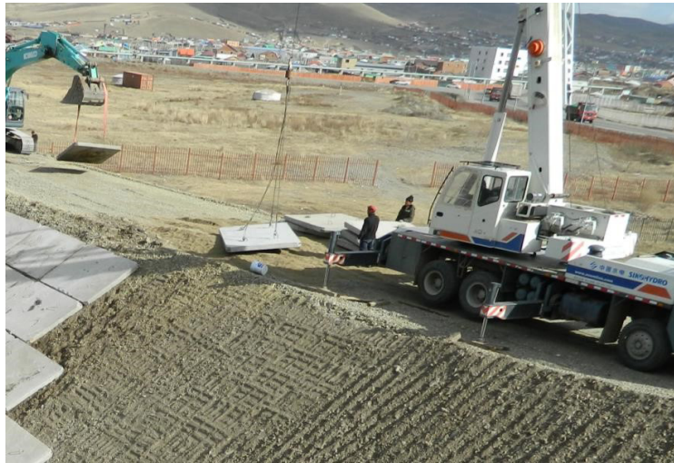
Зураг 8. Төмөр бетон хавтан суурилуулж буй байдал (Жишээ зураг)
