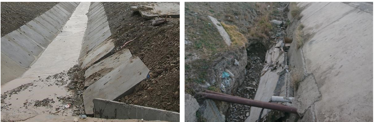
Зураг 37. Үерийн хамгаалалтын барилга байгууламжийн засвар, нөхөн сэргээлт (Жишээ зураг)
